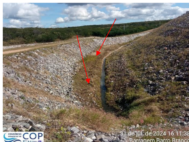
Foto 6.9: Região úmida entre o PZ-12 e MV-02.
