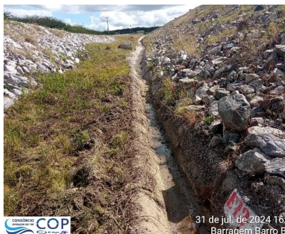
Foto 6.6: Surgências na canaleta no pé do talude de jusante.
