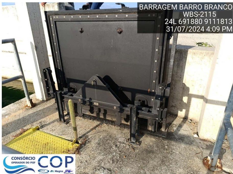
Foto 6.27: Comporta ensecadeira e viga pescadora com sinais de oxidação.
