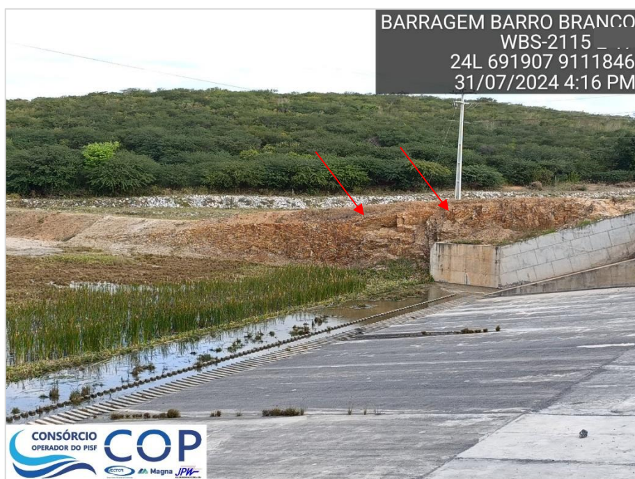
Foto 6.17: Erosões no talude natural direito do vertedouro.
