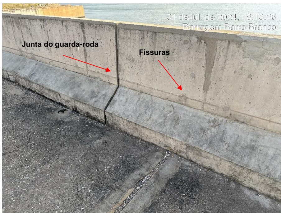
Foto 6.19: Vista do guarda roda de proteção da ponte sobre o vertedouro.
