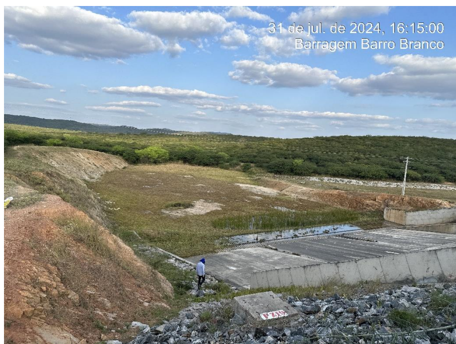
Foto 6.15: Vista do canal de restituição do vertedouro.
