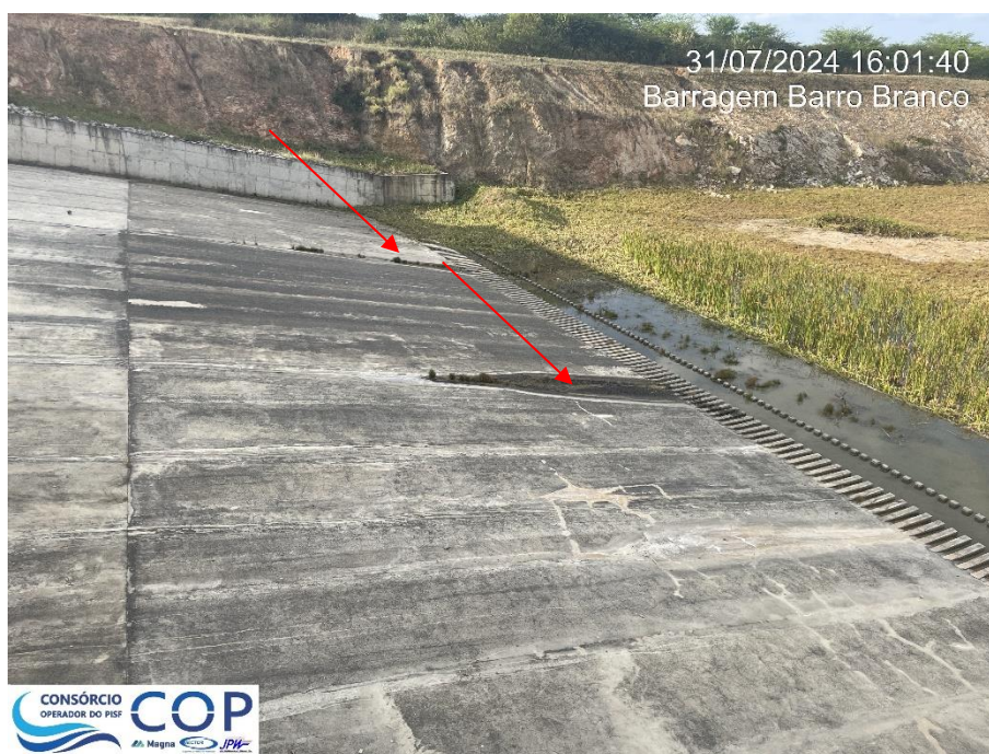
Foto 6.20: Trincas superficiais e surgência nas juntas da estrutura do rápido.
