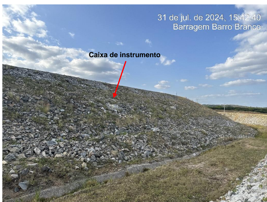
Foto 6.13: Vista da caixa da instrumentação, instalada no talude de jusante, que apresenta dificuldade de acesso.
