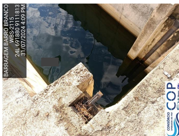
Foto 6.29: Guia de descida da comporta/grade de proteção com sinais de oxidação.
