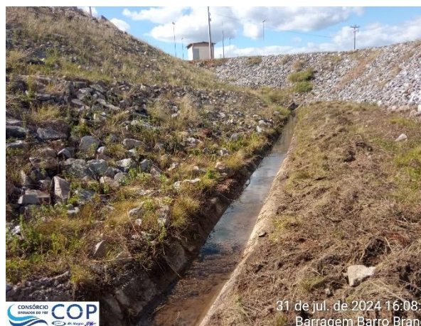
Foto 6.7: Surgências na canaleta no pé do talude de jusante.
