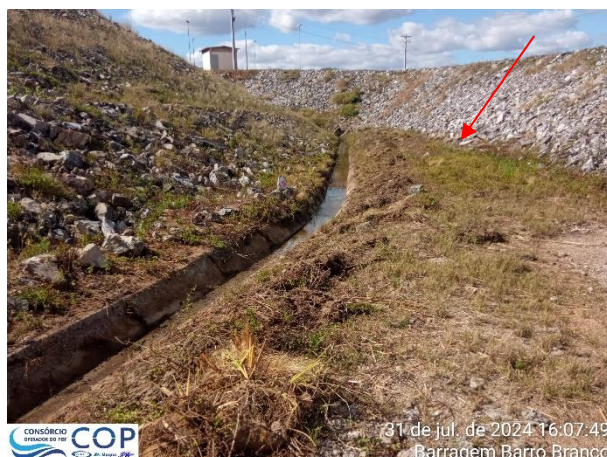
Foto 6.8: Região úmida entre o PZ-12 e MV-02.
