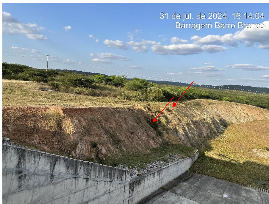
Foto 6.16: Erosões no talude natural esquerdo do vertedouro.
