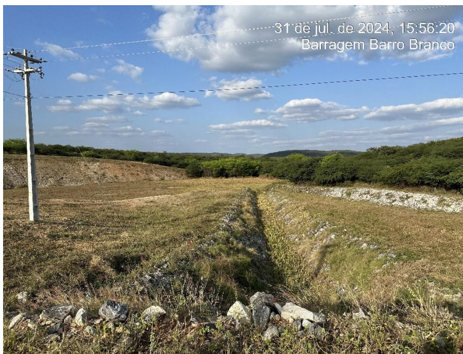
Foto 6.11: Vista do canal de restituição da drenagem interna da barragem.
