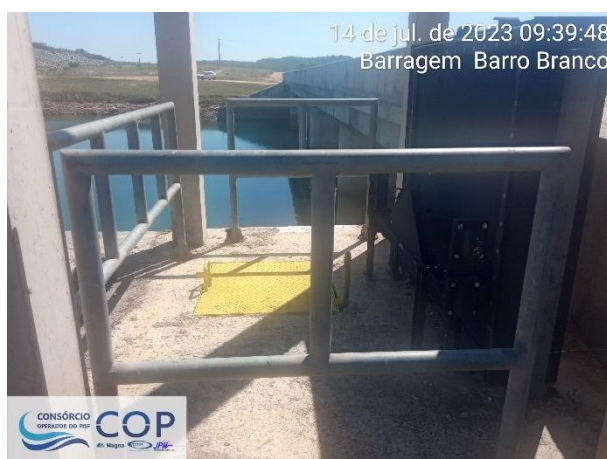
Foto 6.28: Guarda-corpo de proteção com sinais de oxidação.
