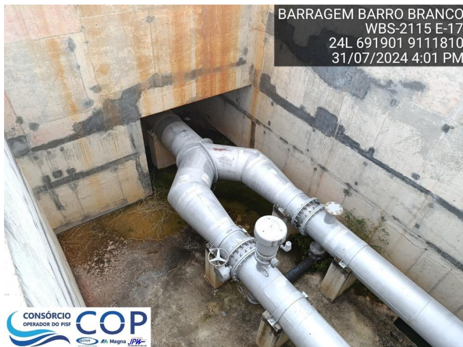
Foto 6.30: Presença de acúmulo de água na entrada da galeria, proveniente das surgências no interior da galeria.
